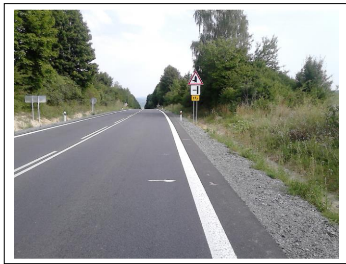
koniec úseku KNL
