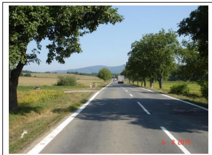
koniec úseku KNL proti smeru staničenia
