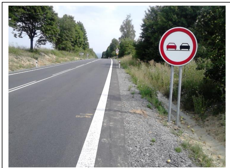
začiatok úseku KNL
