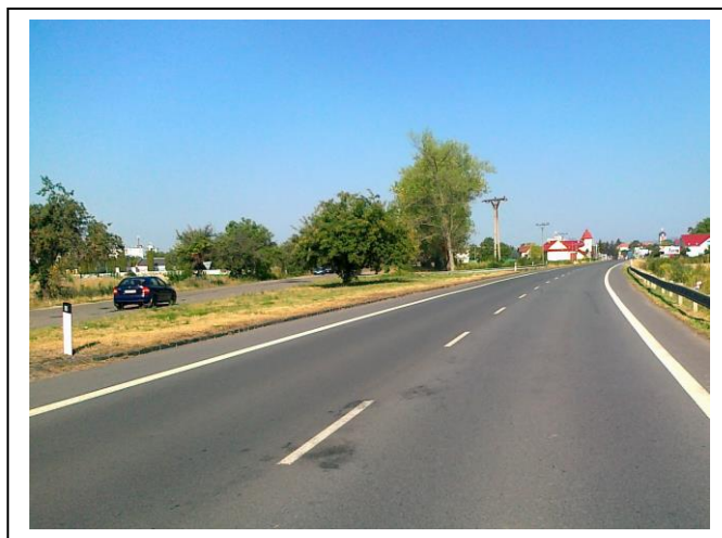
Koniec úseku KNL proti smeru staničenia
