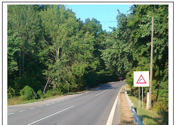
Koniec úseku KNL proti smeru staničenia
