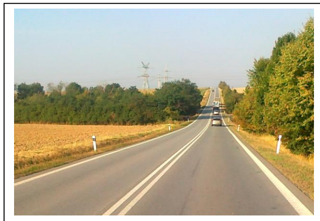
Koniec úseku KNL proti smeru staničenia
