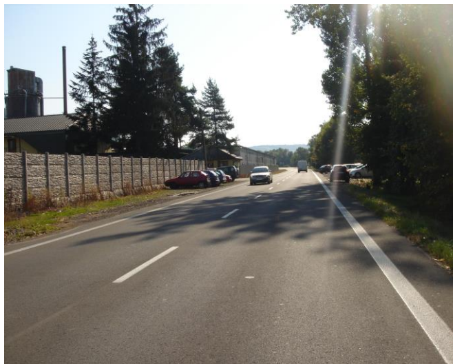
Začiatok úseku KNL v smere staničenia
