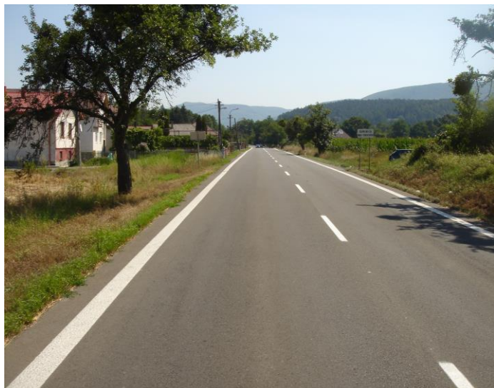
Začiatok úseku KNL v smere staničenia
