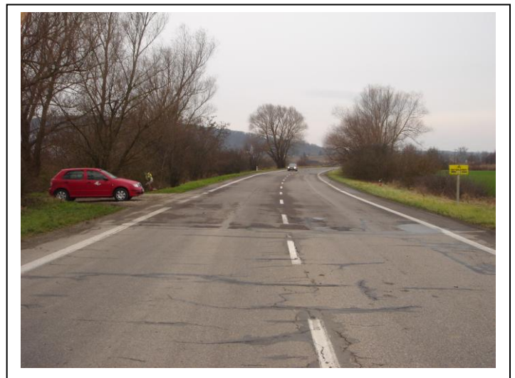
Koniec úseku KNL proti smeru staničenia
