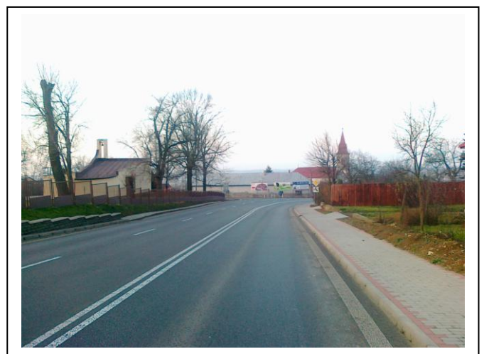
Koniec úseku KNL proti smeru staničenia
