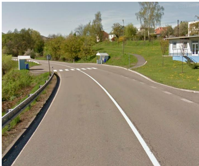
Kritická nehodová lokalita v protismere staničenia
