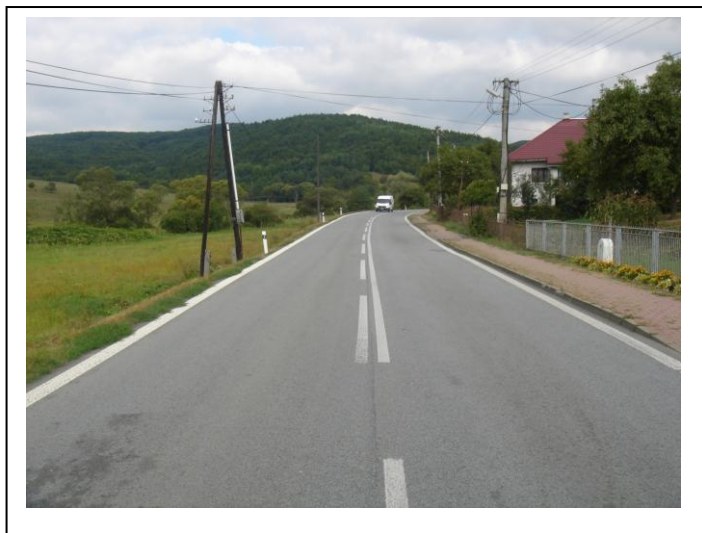
Začiatok kritického miesta v úseku KNL
