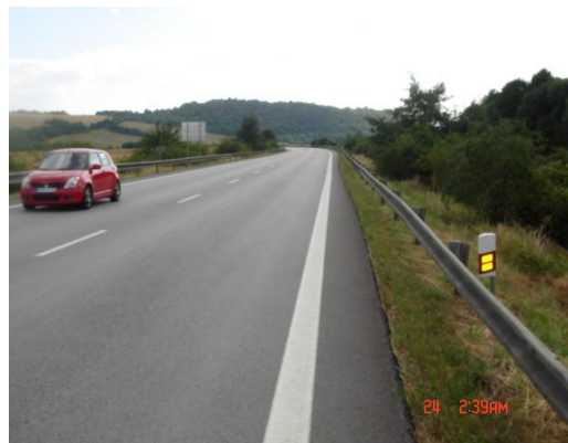
Koniec úseku KNL v smere staničenia
