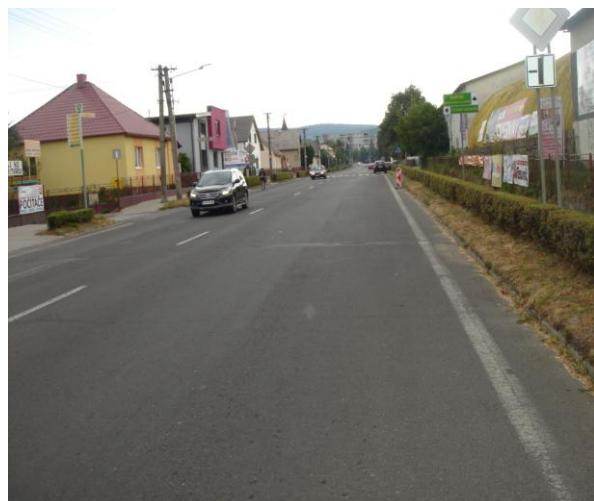
Koniec úseku KNL v smere staničenia
