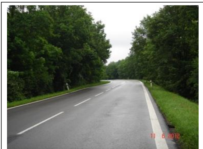
Začiatok úseku KNL v smere staničenia
