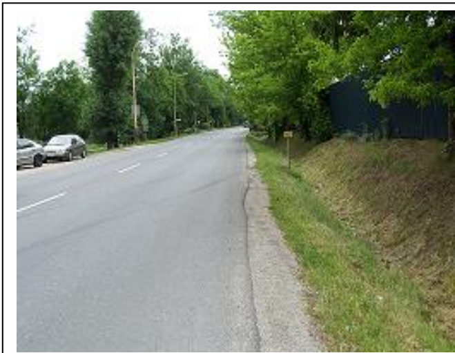
Koniec úseku KNL v smere staničenia
