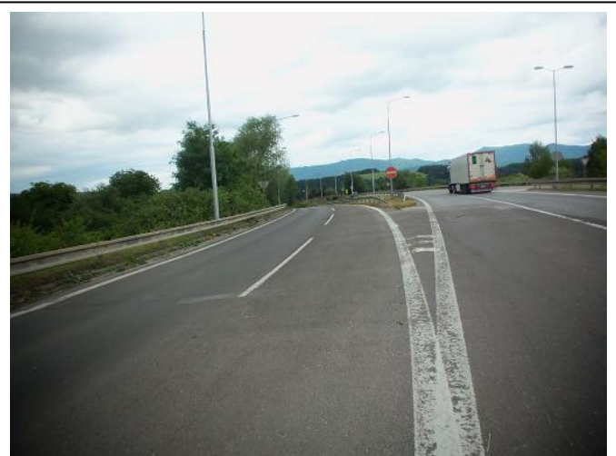
Koniec úseku KNL v smere staničenia
