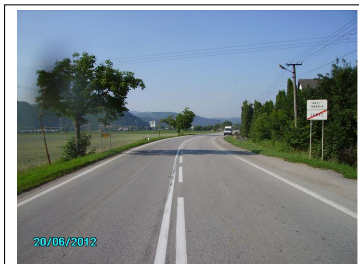
Koniec úseku KNL v smere staničenia
