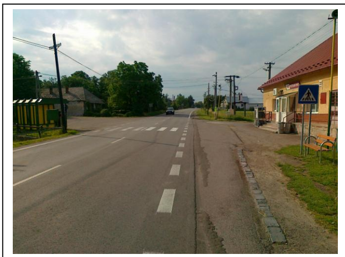
Začiatok úseku KNL v smere staničenia
