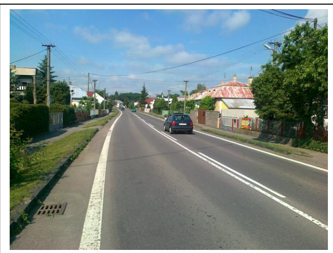
Koniec úseku KNL proti smeru staničenia
