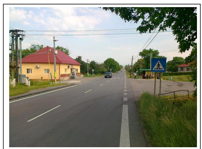
Koniec úseku KNL proti smeru staničenia
