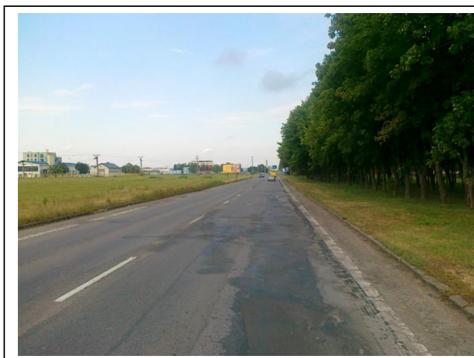
Koniec úseku KNL proti smeru staničenia
