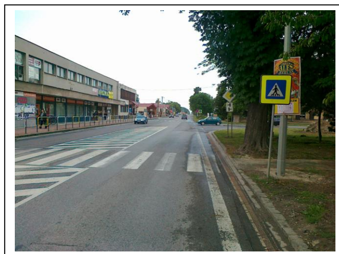
Koniec úseku KNL proti smeru staničenia
