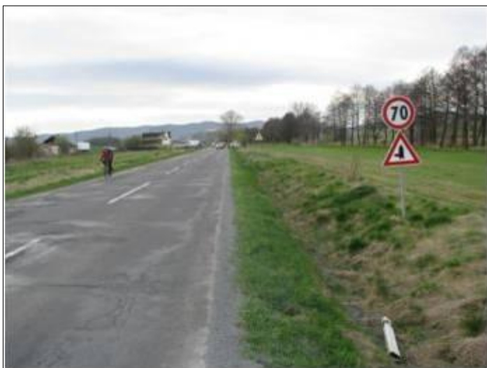
Pohľad na KNL pred opravou krytu
