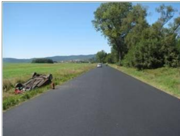
Pohľad na KNL po oprave krytu v čase nehody
