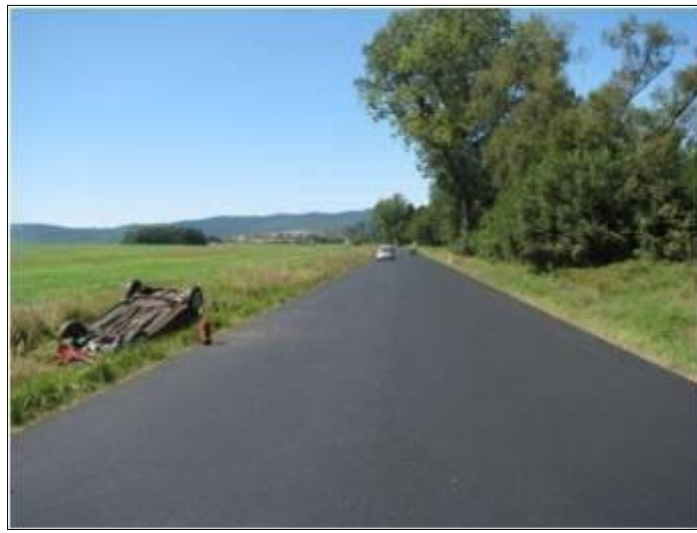
Pohľad na KNL po oprave krytu v čase nehody
