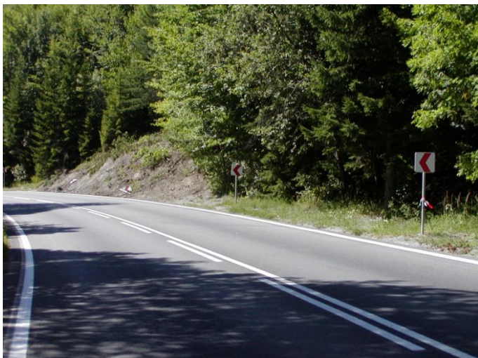
Pohľad na cestu I/59 v smere staničenia
