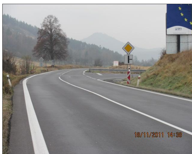
KNL proti smeru staničenia, vpravo výjazd na privádzac R1
