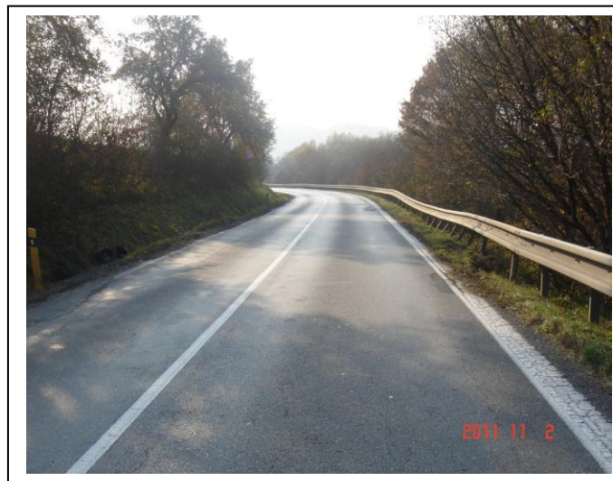
Koniec úseku KNL
