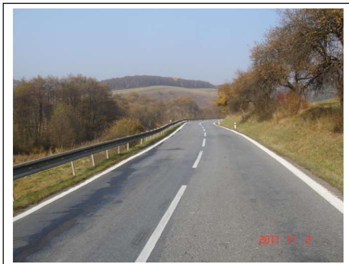
Začiatok úseku KNL
