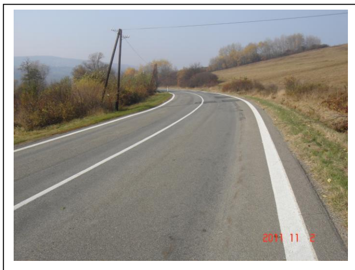
Začiatok úseku KNL
