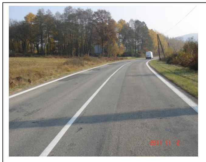
Koniec úseku KNL
