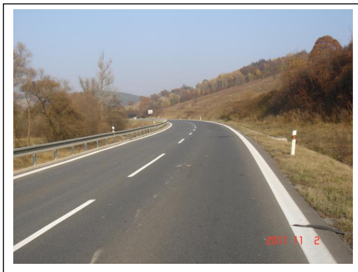
Začiatok úseku KNL
