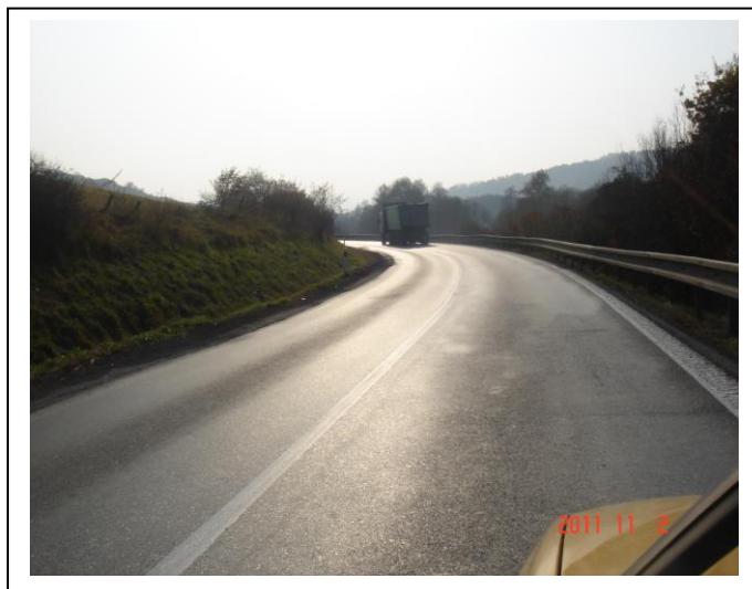
Koniec úseku KNL
