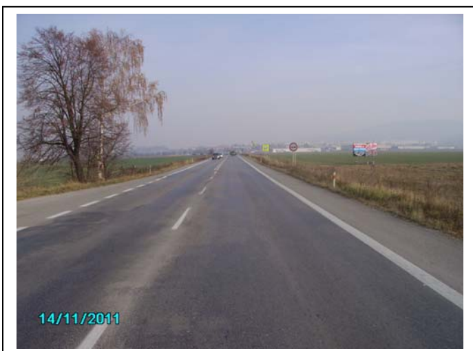
Začiatok úseku KNL v smere staničenia
