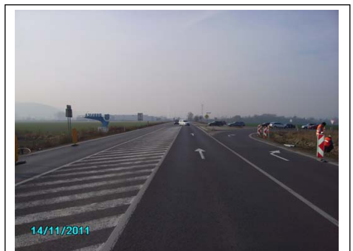
Koniec úseku KNL v smere staničenia
