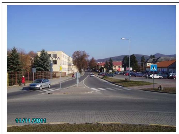
Začiatok úseku KNL v smere staničenia
