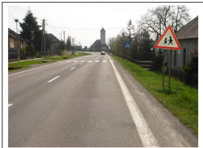
Začiatok úseku KNL v smere staničenia
