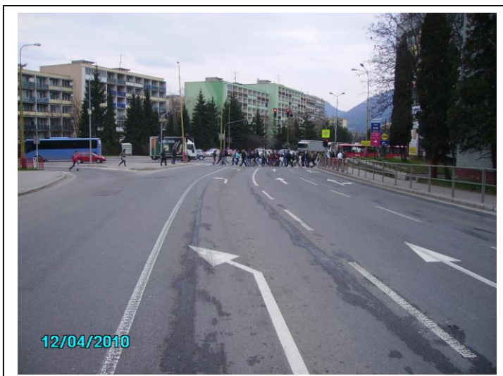
Začiatok úseku KNL v smere staničenia
