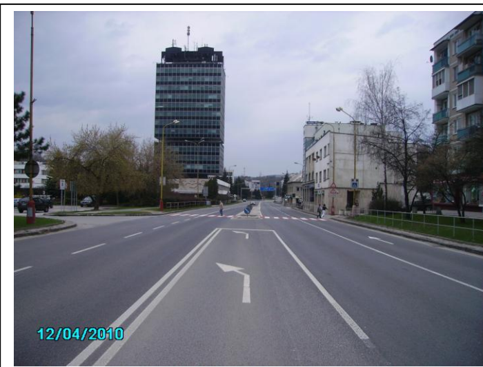
Koniec úseku OKNL v smere staničenia
