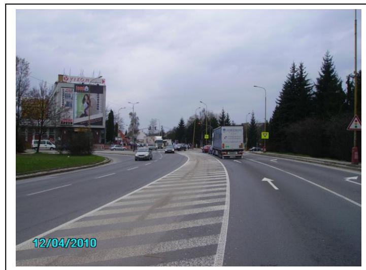
Koniec úseku KNL v smere staničenia
