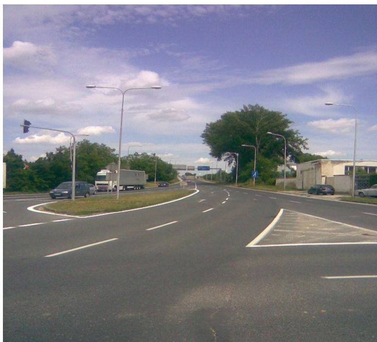
Koniec úseku KNL v smere staničenia
