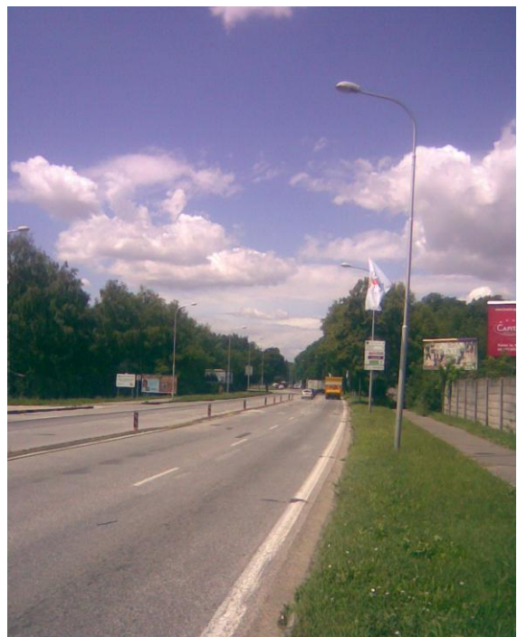
Koniec úseku KNL v smere staničenia
