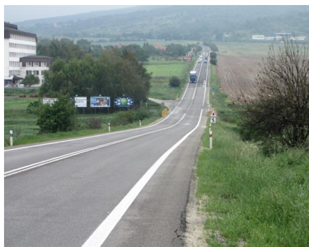
Koniec úseku KNL v protismere staničenia
