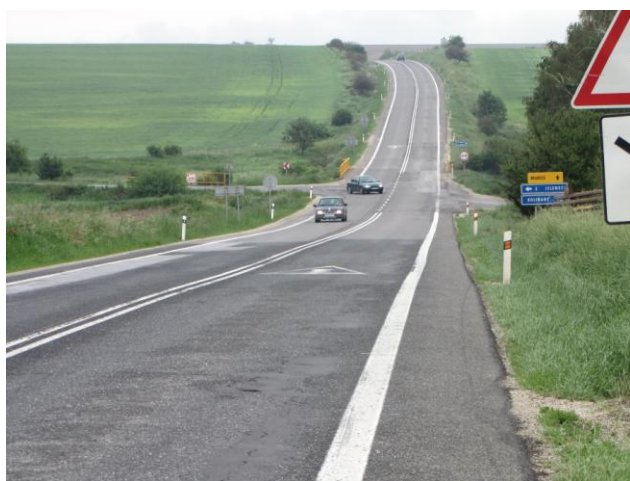
Začiatok úseku KNL v smere staničenia
