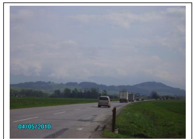
Koniec úseku KNL v protismere staničenia
