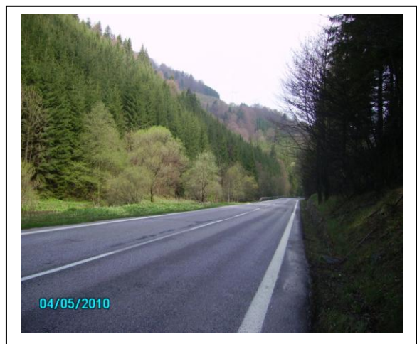
Koniec úseku KNL v protismere staničenia
