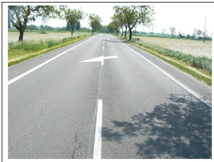
Začiatok úseku km 81,950
