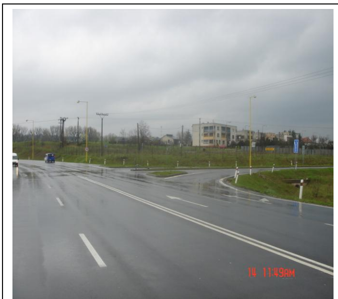
Začiatok úseku KNL v smere staničenia
