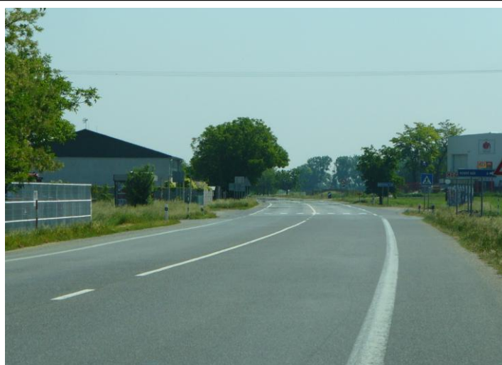
Začiatok úseku KNL v smere staničenia
