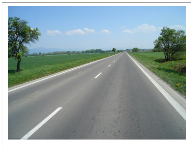
Začiatok úseku KNL v smere staničenia
