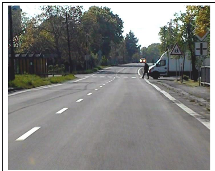
Začiatok úseku KNL v smere staničenia
