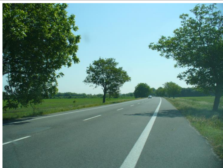
Začiatok úseku KNL v smere staničenia
