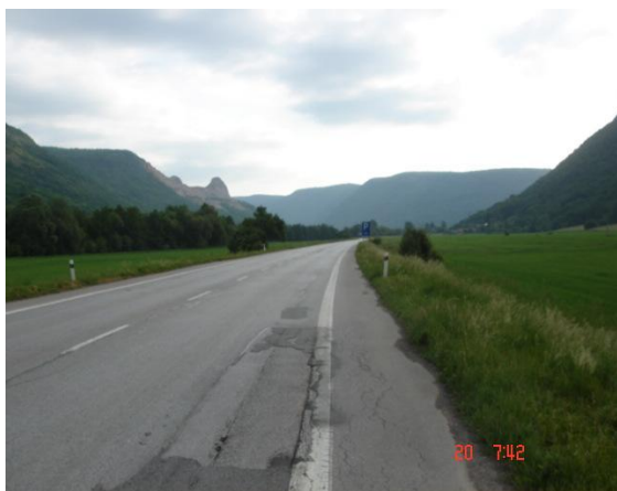
Začiatok úseku KNL v smere staničenia
