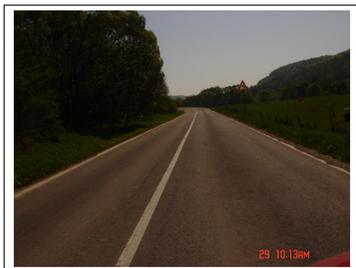
Začiatok úseku KNL v smere staničenia
