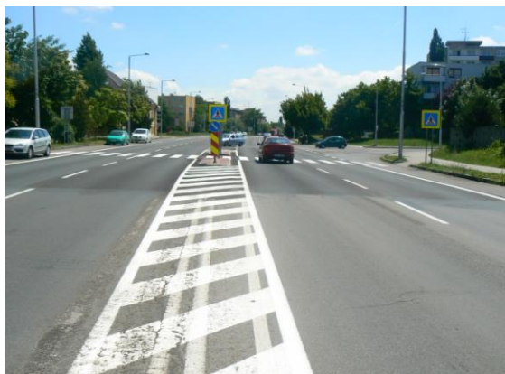
Začiatok úseku OKNL v smere staničenia
