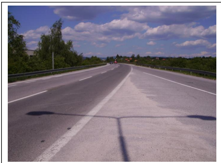
Začiatok úseku OKNL v smere staničenia
