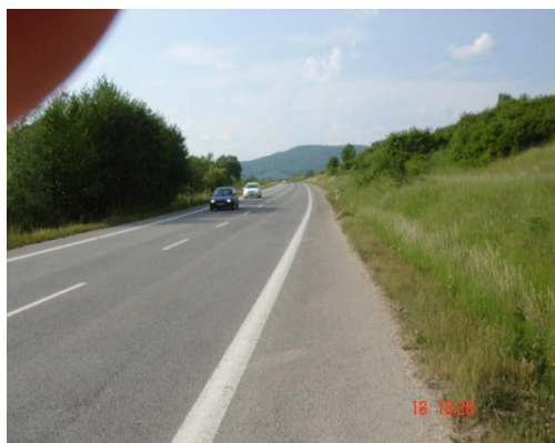
Začiatok úseku KNL v smere staničenia
