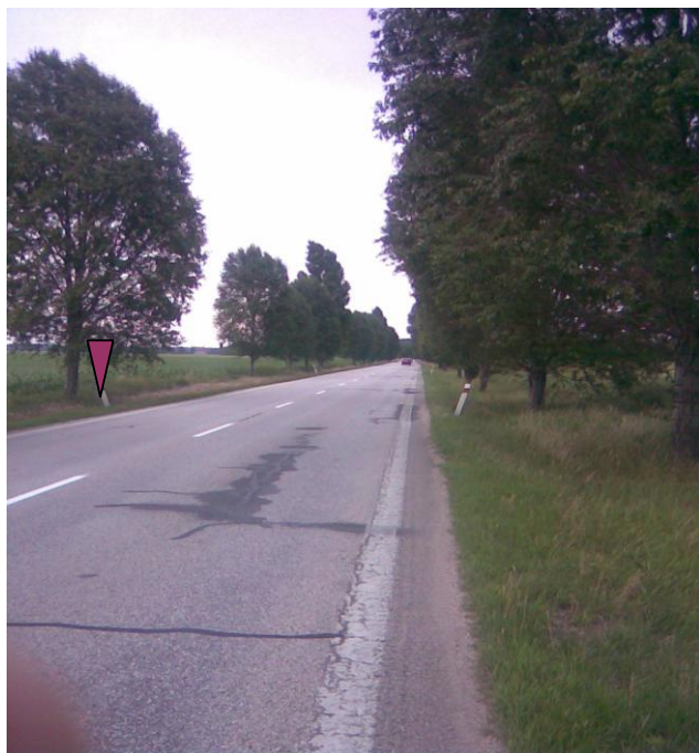
Začiatok úseku KNL v smere staničenia
