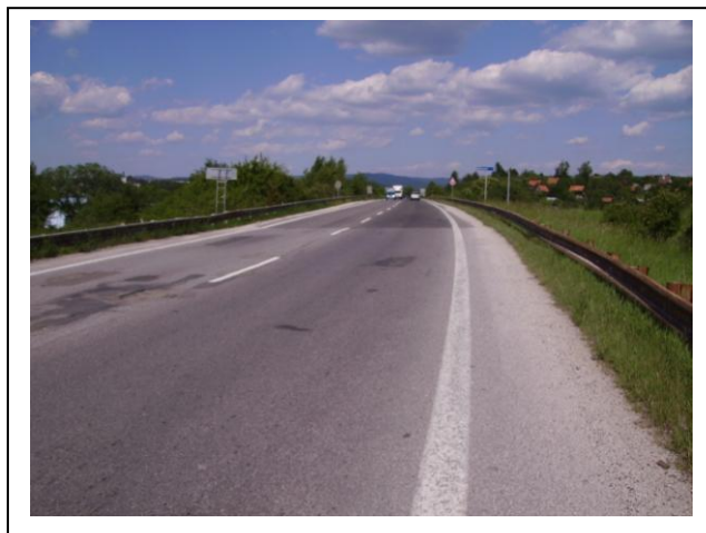
Koniec úseku OKNL v smere staničenia
