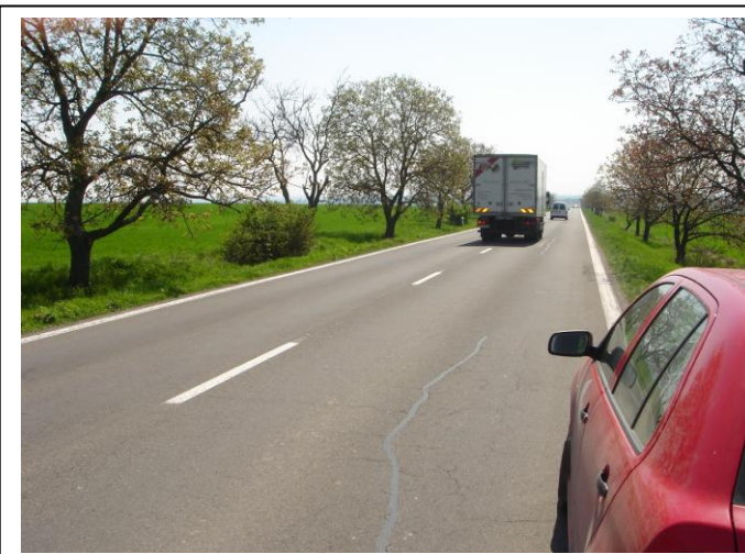
Začiatok úseku KNL v smere staničenia
