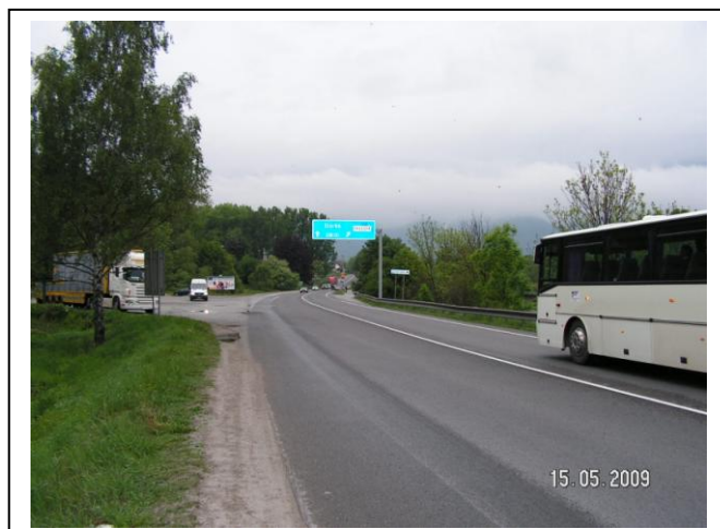
Pohľad do OKNL proti smeru staničenia
