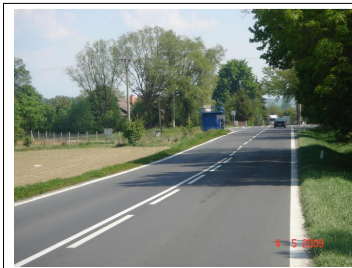
Začiatok úseku KNL v smere staničenia
