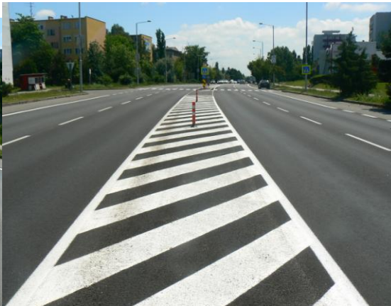
Koniec úseku OKNL v smere staničenia
