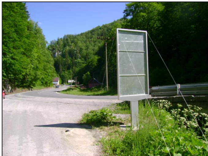
Pohľad na cestu I/14 z poľnej cesty
