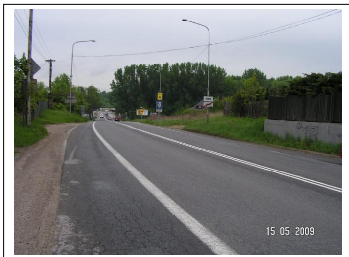
Pohľad do OKNL v smere staničenia
