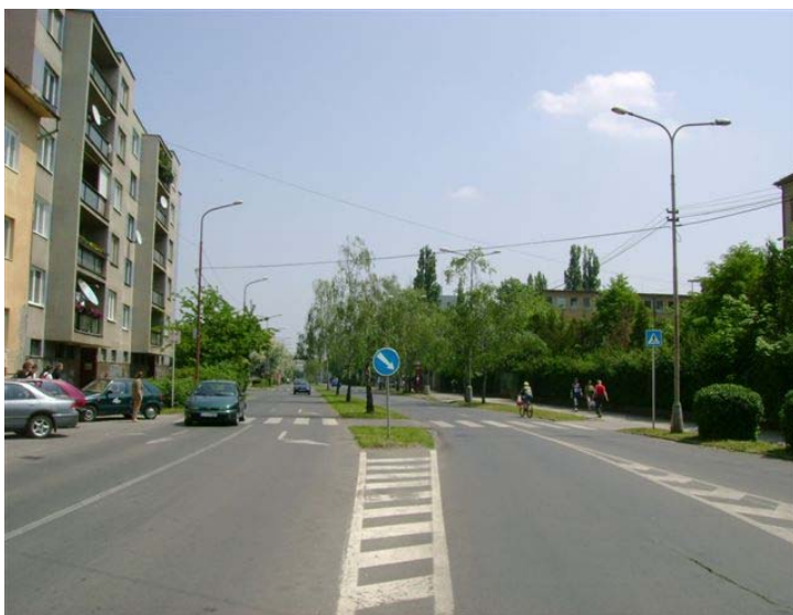
Úsek KNL v smere staničenia, cesta I/75 Haličská cesta
