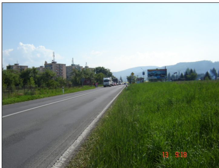
Začiatok KNL vstup do obce Hliník nad Hronom
