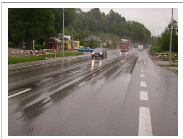
Začiatok úseku KNL v km 433,750
