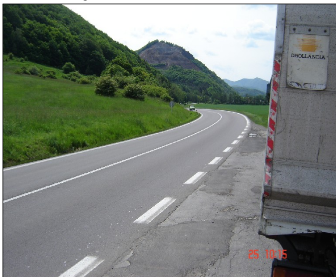
Úseku KNL v protismere staničenia
