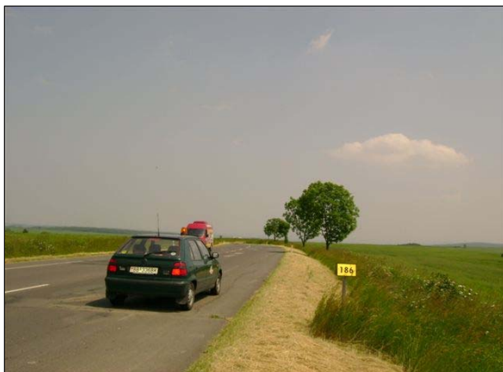
Začiatok úseku KNL v smere staničenia v km 186,000
