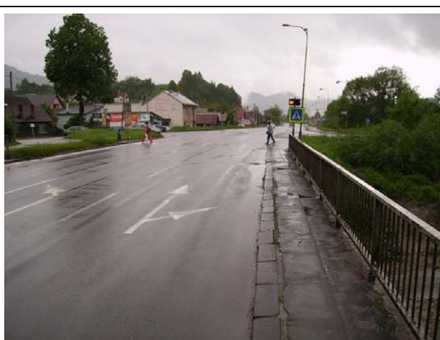
Koniec úseku KNL v km 434,100
