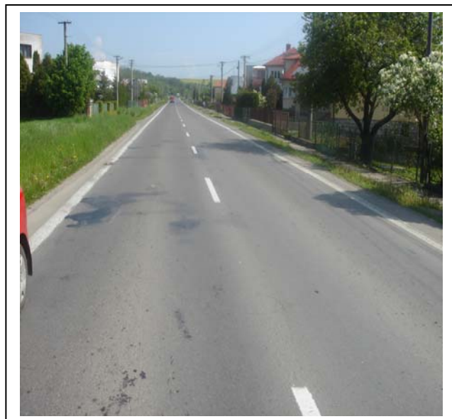
KNL proti smeru staničenia na ceste v km 4,100
