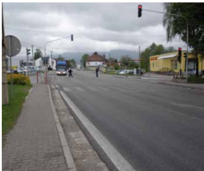
Koniec úseku OKNL v smere staničenia
