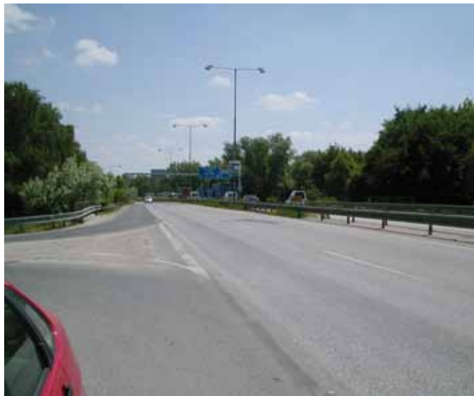
Koniec úseku OKNL v smere staničenia
