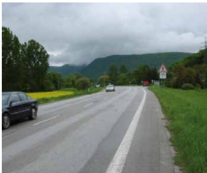
Koniec úseku OKNL v smere staničenia
