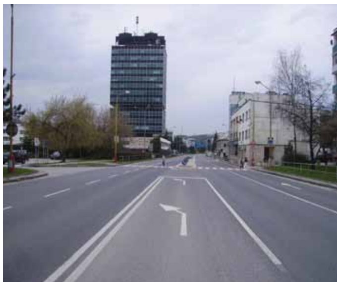
Koniec úseku OKNL v smere staničenia
