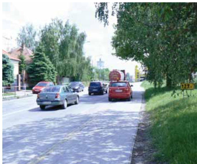
Koniec úseku OKNL v smere staničenia
