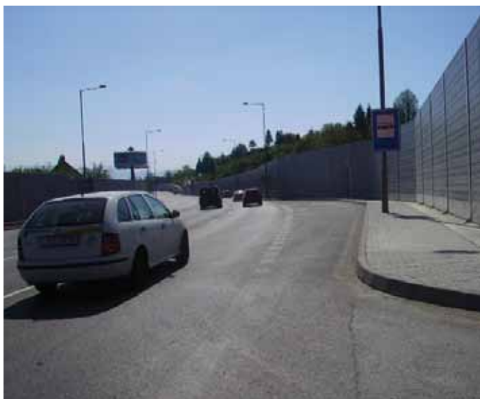
Začiatok úseku OKNL v smere staničenia
