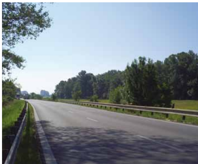
Začiatok úseku OKNL v smere staničenia
