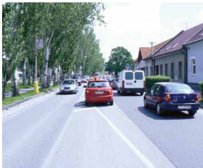
Začiatok úseku OKNL v smere staničenia
