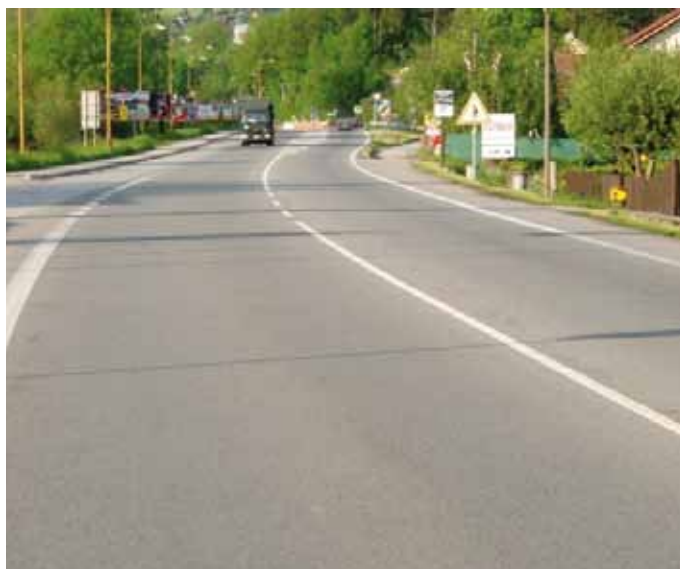
Koniec úseku OKNL v smere staničenia
