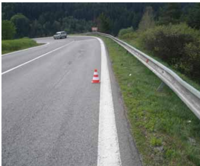
Začiatok úseku OKNL v smere staničenia
