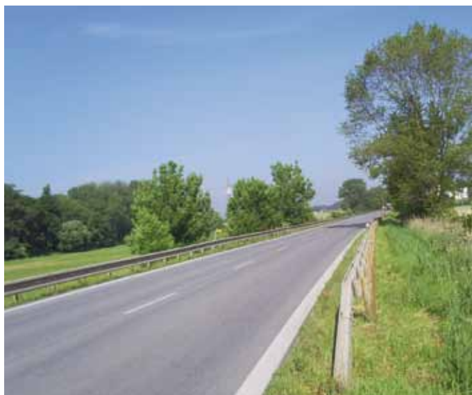
Koniec úseku OKNL v smere staničenia
