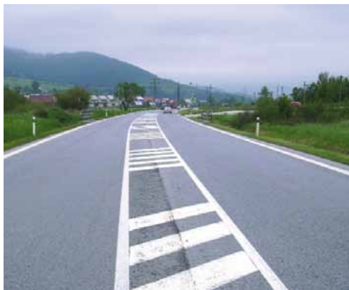
Začiatok úseku OKNL v smere staničenia
