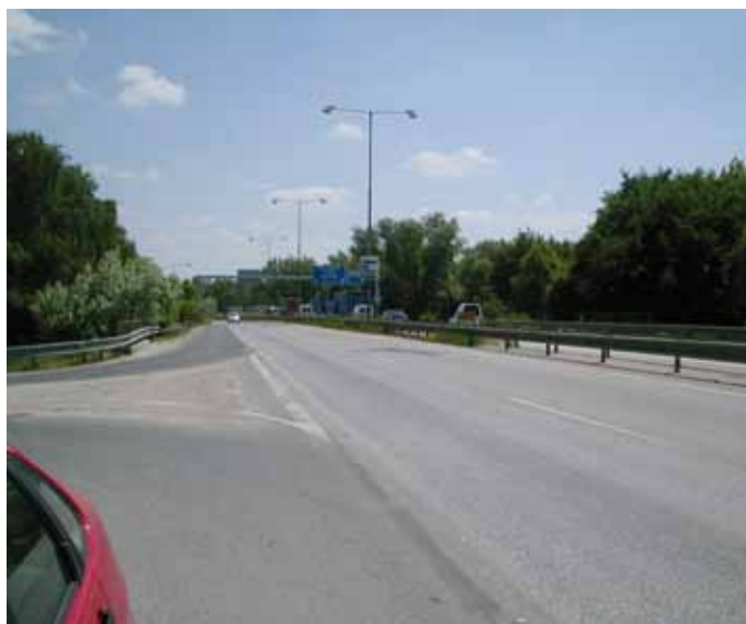
Koniec úseku OKNL v smere staničenia
