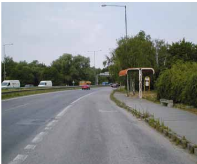
Začiatok úseku OKNL v smere staničenia
