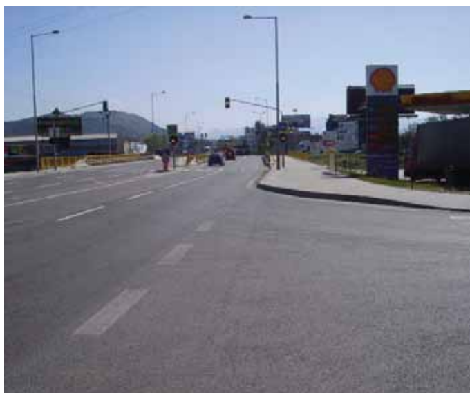
Koniec úseku OKNL v smere staničenia
