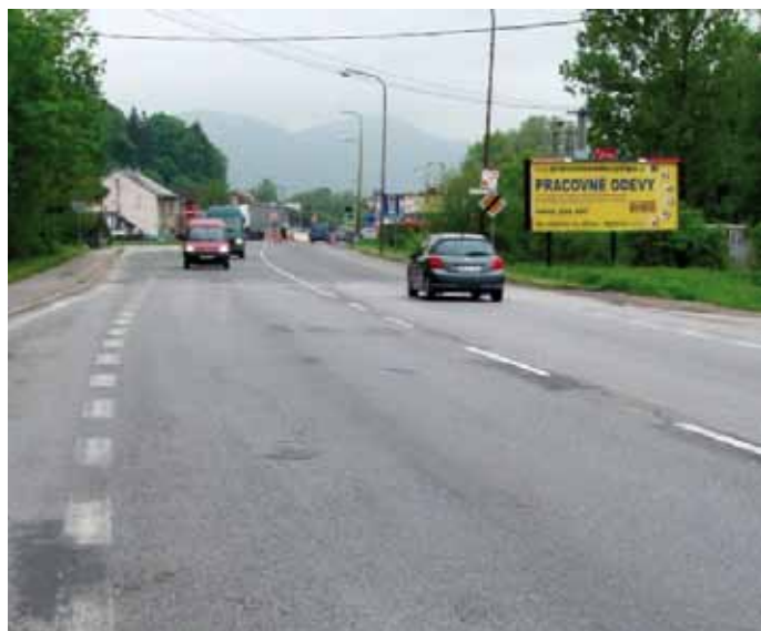
Začiatok úseku OKNL v smere staničenia
