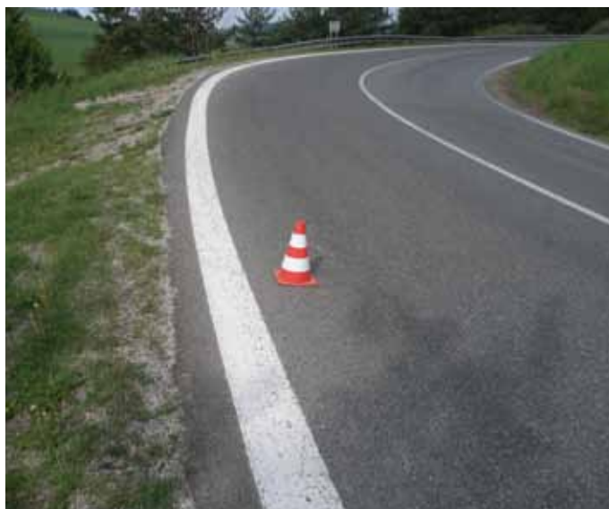
Koniec úseku OKNL v smere staničenia
