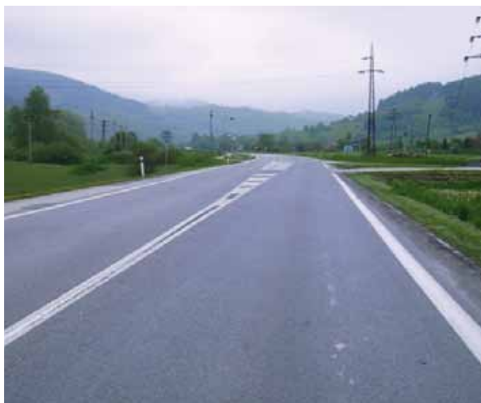
Koniec úseku OKNL v smere staničenia
