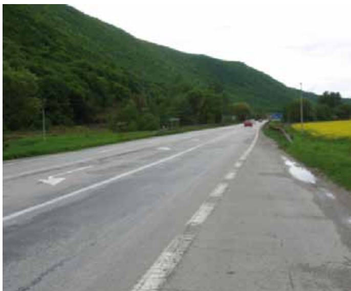
Začiatok úseku OKNL v smere staničenia
