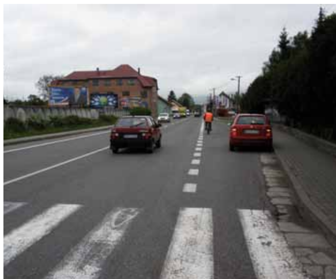
Začiatok úseku OKNL v smere staničenia
