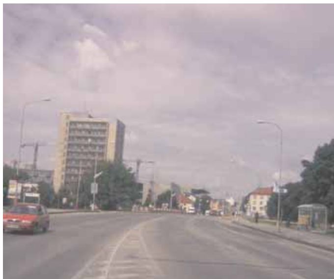
Koniec úseku OKNL v smere staničenia
