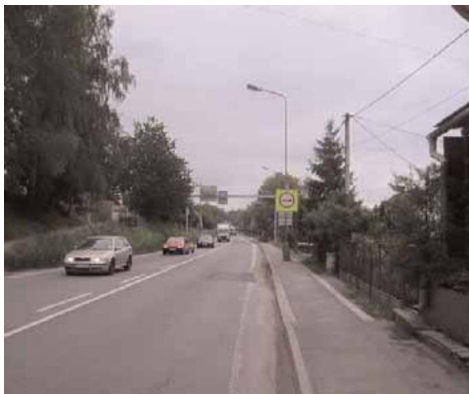
Koniec úseku OKNL v smere staničenia
