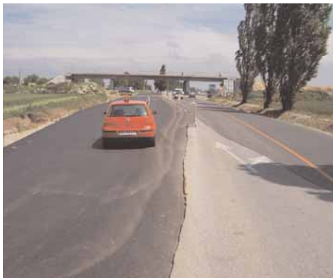
Koniec úseku OKNL v smere staničenia
