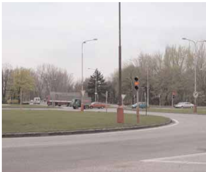
Koniec úseku OKNL v smere staničenia
