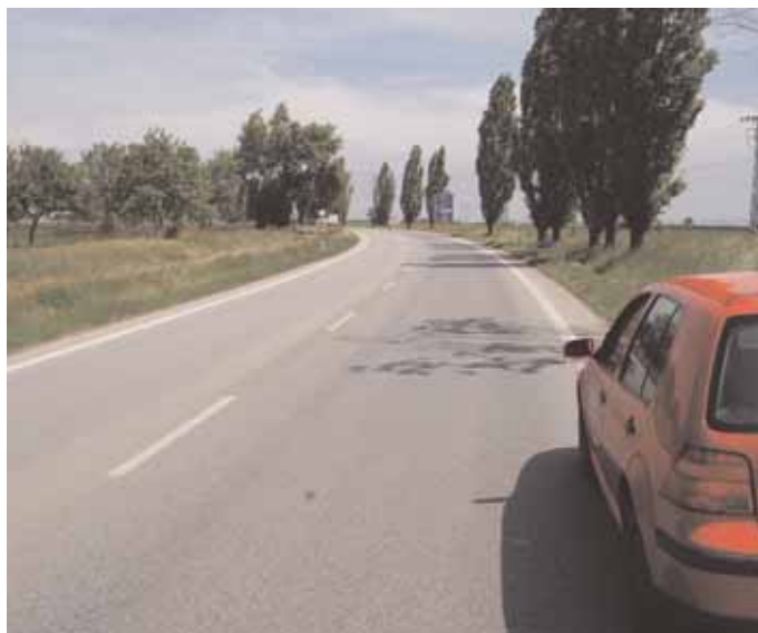
Koniec úseku OKNL v smere staničenia
