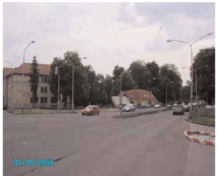
Koniec úseku OKNL v smere staničenia
