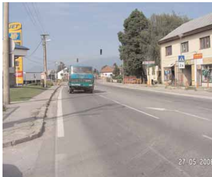
Koniec úseku OKNL proti smeru staničenia
