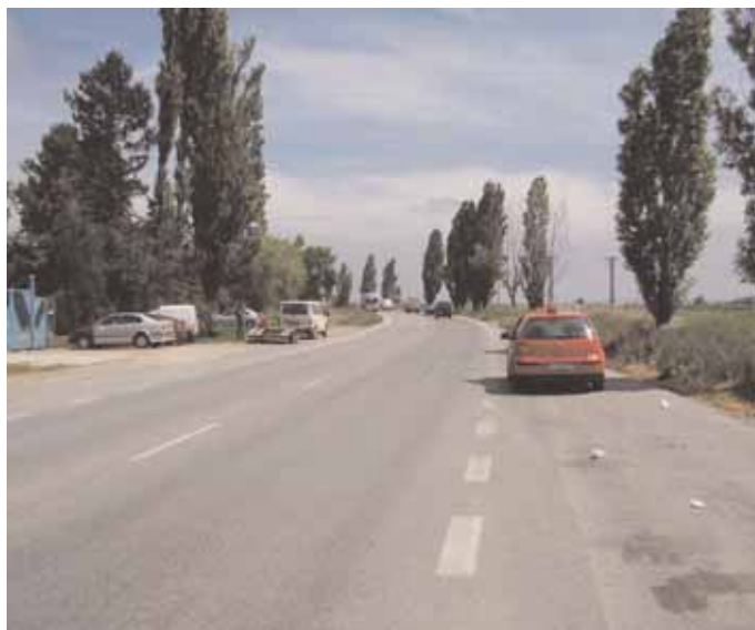
Koniec úseku OKNL v smere staničenia
