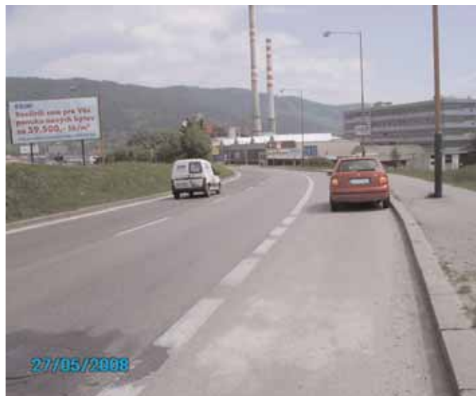
Koniec úseku OKNL v smere staničenia
