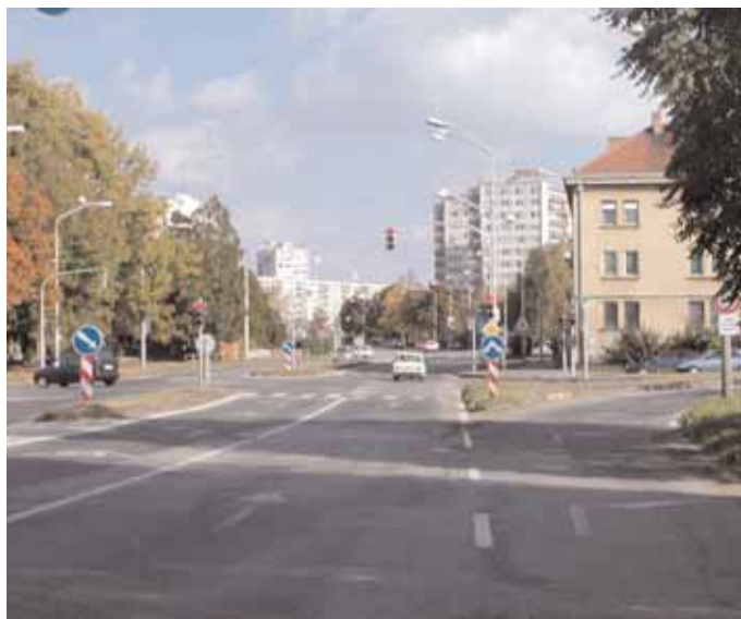
Koniec úseku OKNL v smere staničenia
