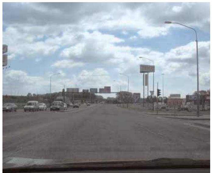
Koniec úseku OKNL za križovatkou v smere staničenia
