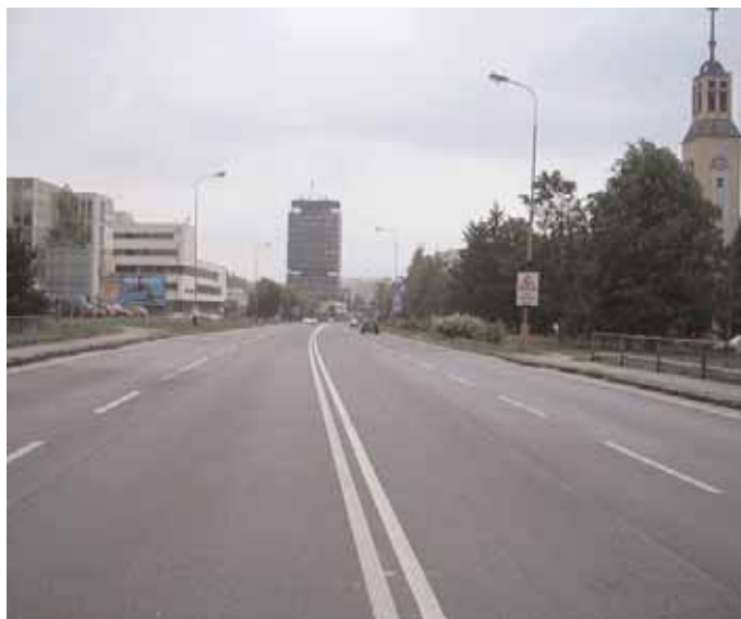
Koniec úseku OKNL v smere staničenia
