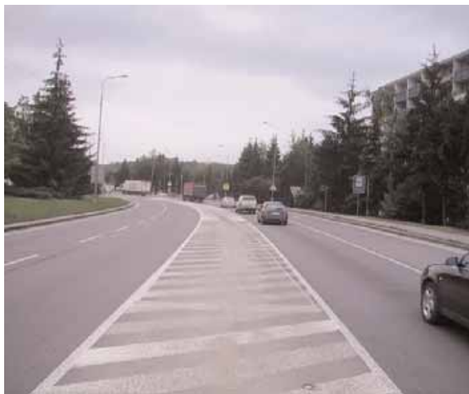
Koniec úseku OKNL v smere staničenia
