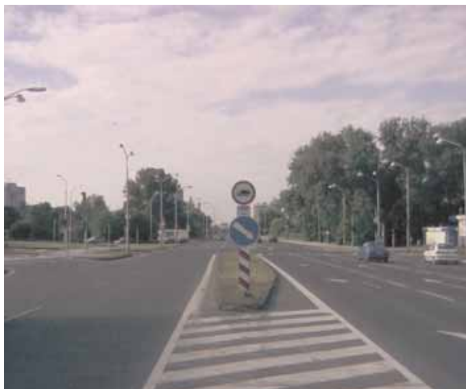
Koniec úseku OKNL v smere staničenia
