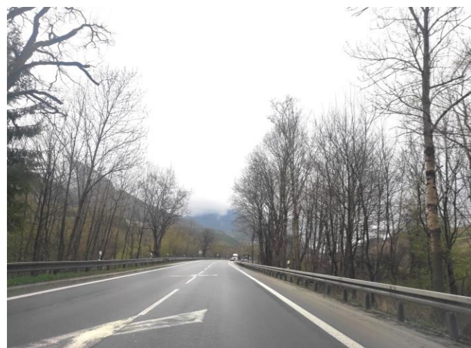
Začiatok úseku NL v smere staničenia
