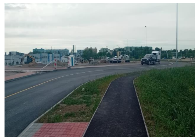
Začiatok úseku NL v smere staničenia 193,700 km
