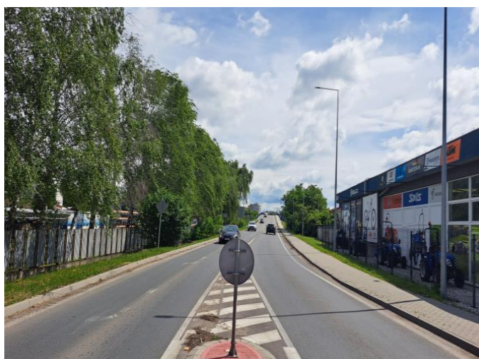
Začiatok úseku NL v smere staničenia 217,560 km
