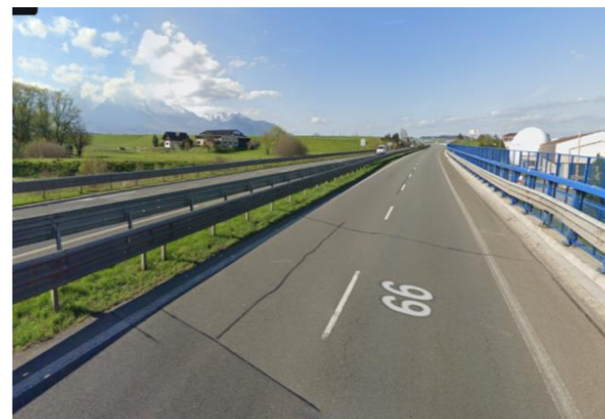
Začiatok úseku NL v smere staničenia
