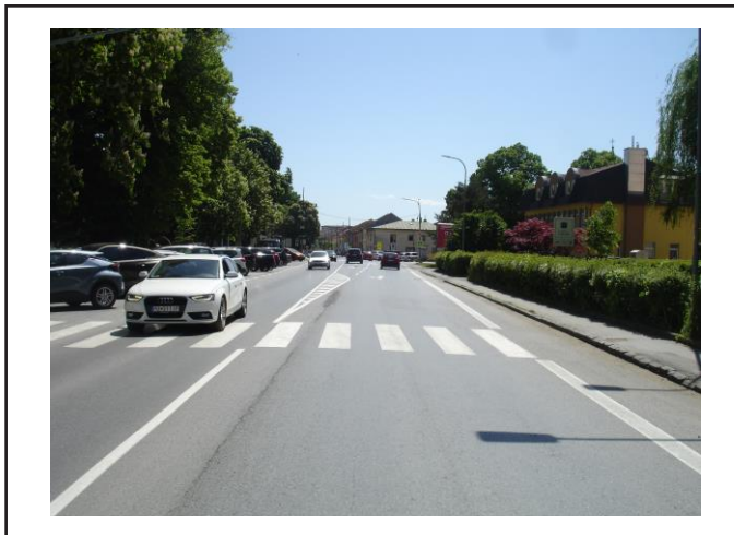
Začiatok úseku NL v smere staničenia
